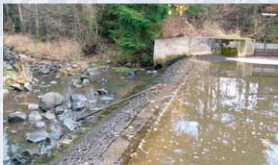
Nepovolená regulace průtoku vod u MVE:
